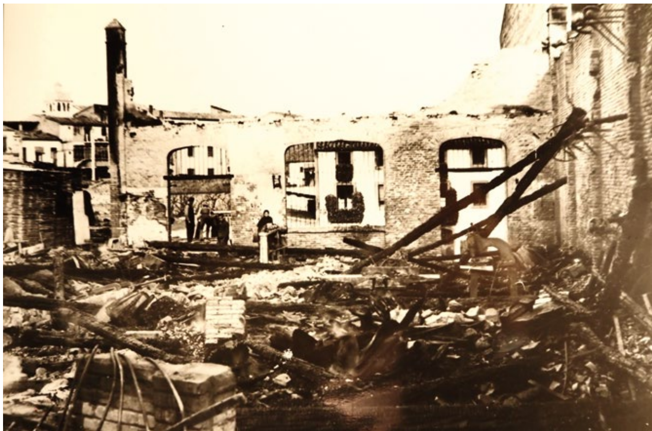
Estat en què va quedar l'ebenisteria Tardà del carrer Saclosa després de l'incendi del 5 de gener de 1933 (arxiu de Llorenç Gamisans)
