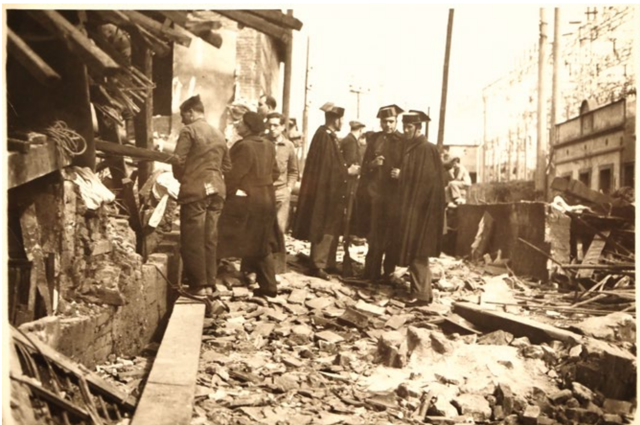
Tasques de rescat a la fàbrica Carreras dels Dolors després de l'explosió de la caldera de calefacció el 6 de març de 1936 (arxiu de Llorenç Gamisans)
