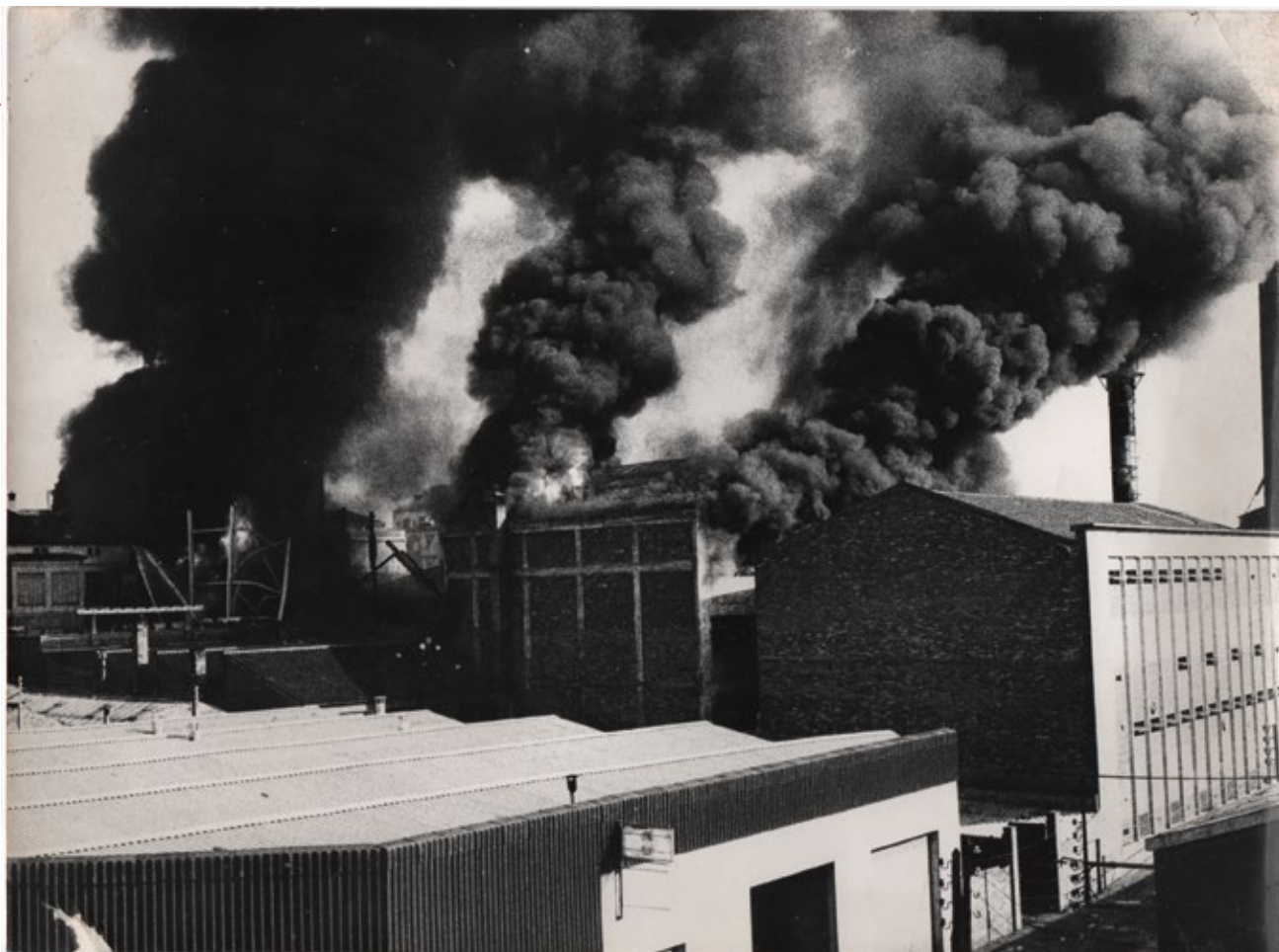
Incendi de l'Auxiliar Textil Manresana de la carretera de Vic del 10 de setembre de 1974 (foto d'Antoni Quintana Torres)
