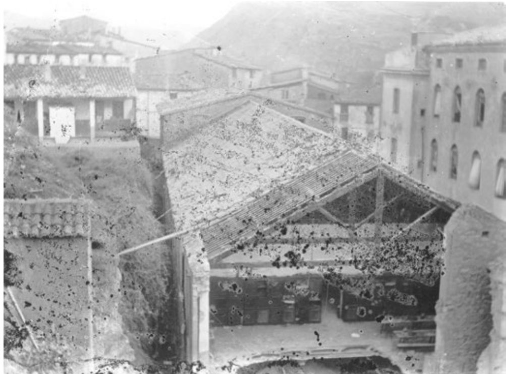
Instal·lacions de les fàbriques Regordosa i Jover, del Pont de Vilomara, just després de l'explosió de la caldera de vapor. En primer terme es veu el menjador de la fàbrica Regordosa amb un esvoranc al terra i sense coberta ni mur lateral (foto de Lluís G. Cornet, cedida per Ramon Cornet a l'ACB)
