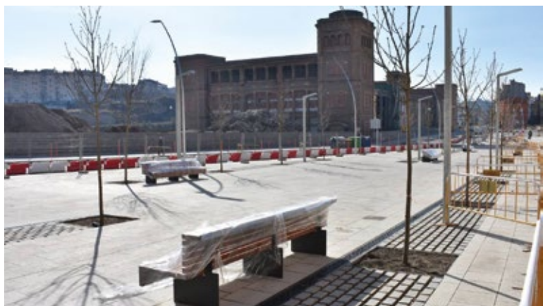
Obres d'urbanització a la Fàbrica Nova (Ajuntament de Manresa)
