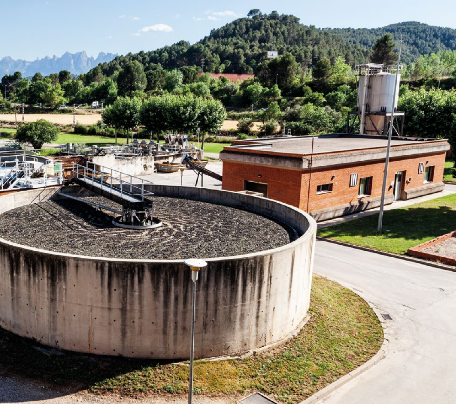
Depuradora i planta de compostatge de fangs
