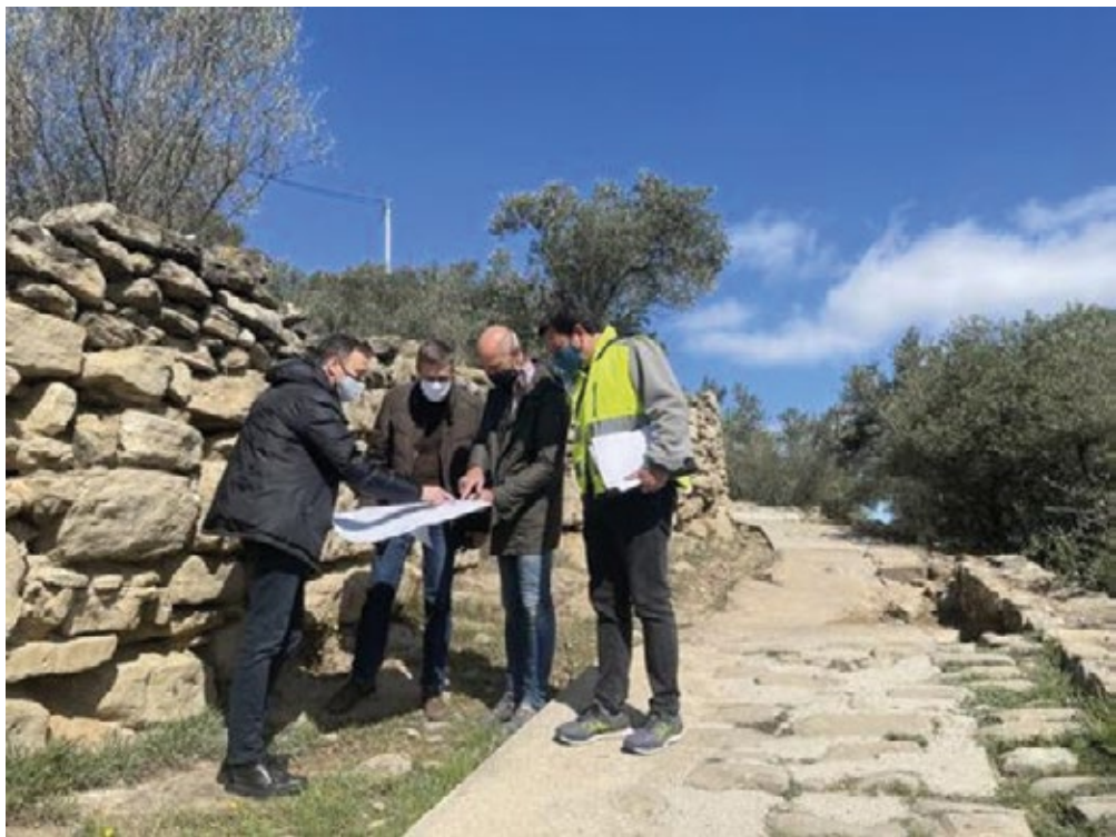
Seguiment dels treballs de restauració del camí ignasià a l'entorn de Santa Caterina
