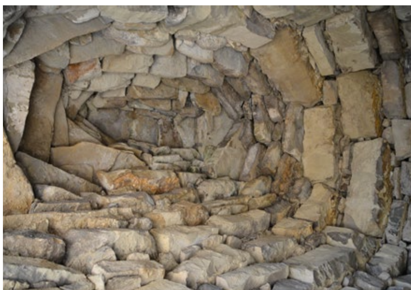
Detall del tancament de la coberta d'una barraca en falsa cúpula (foto: J. Plans)
