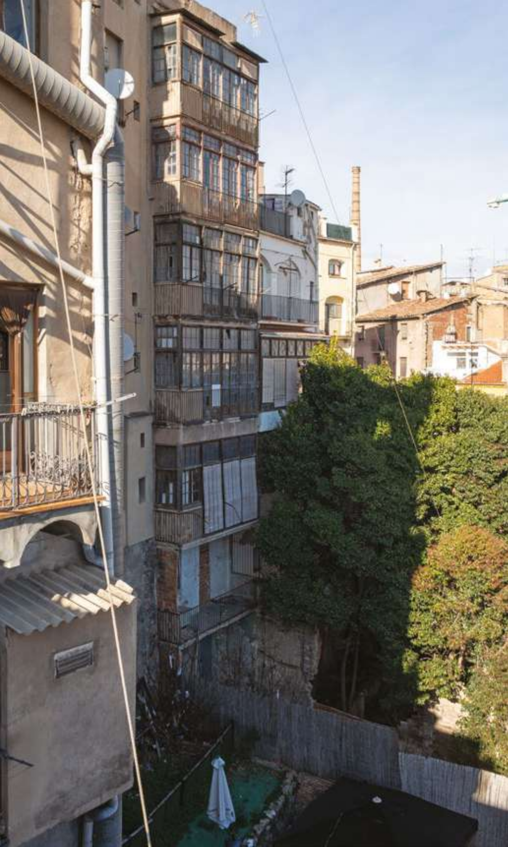
Façana posterior de la casa Oms i de Prat (foto: Enric Casas)
