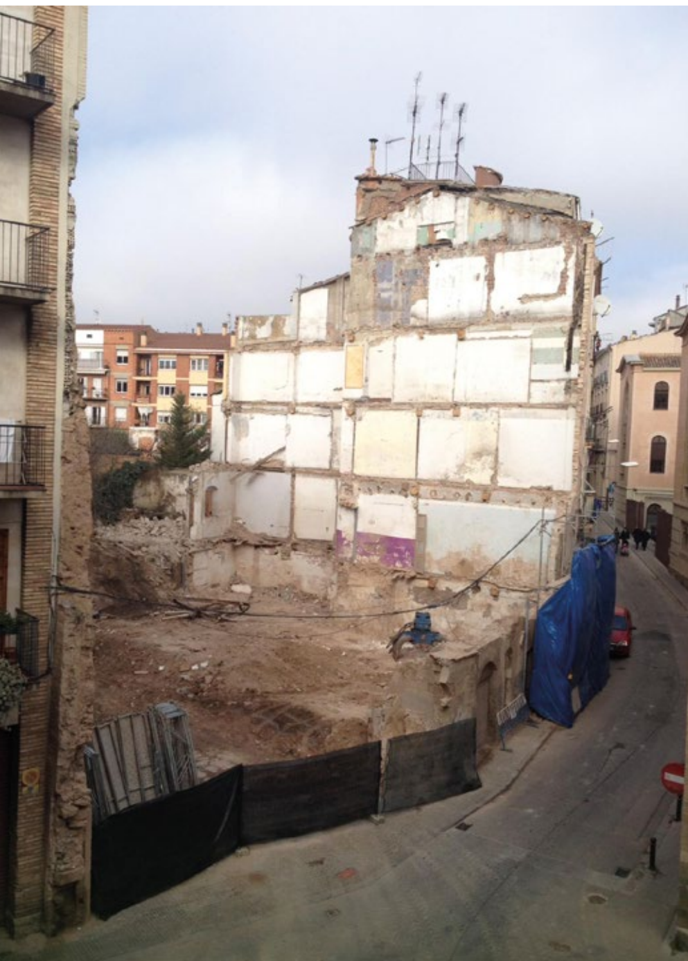
Sòl municipal del carrer de l'Hospital on es construirà l'edifici de La Raval. Foto: Jordi Sitjà Prats
